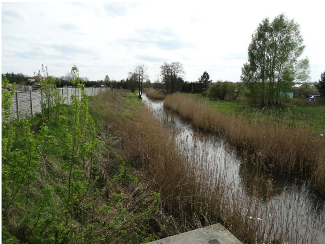
Zdjęcie Nr 8. Wgląd na koryto rz. Rawki od strony mostu kolejki wąskotorowej.
