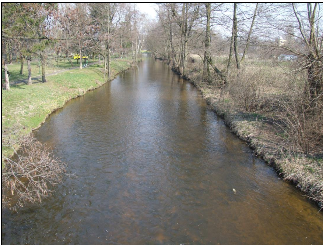
Zdjęcie Nr 6. Wgląd na koryto rz. Rawki od strony ul. Fawornej. Po stronie lewej „Park Miejski” wpisany do rejestru zabytków.
