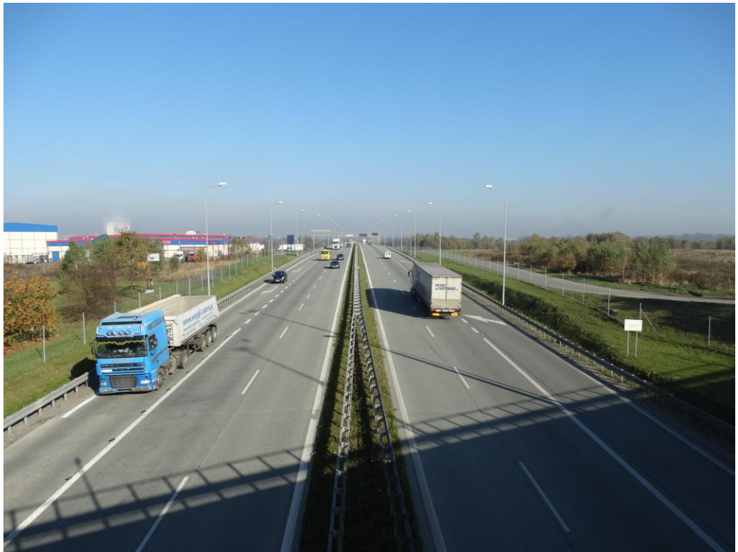
Zdjęcie Nr 14. Droga S8 z węzła Rawa Północ w kierunku Warszawy.
