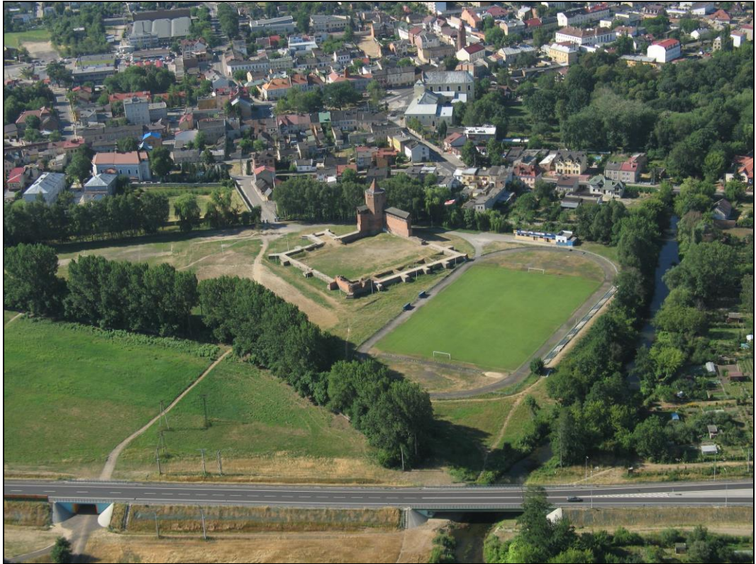
Zdjęcie Nr 27. Wgląd na „Zamek Książąt Mazowieckich” od strony północnej. Na pierwszym planie droga krajowa Nr 72.
