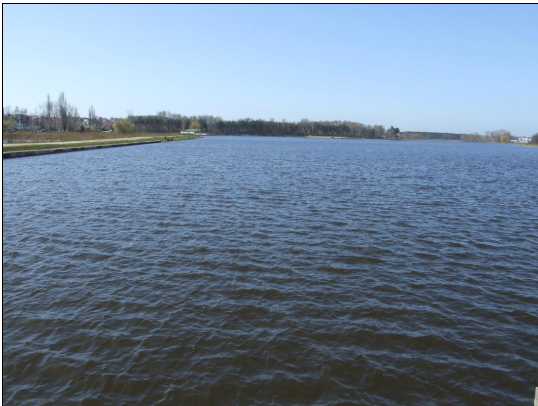
Zdjęcie Nr 5. Wgląd na południowy brzeg zbiornika „Rawa Dolna” od strony zapory czołowej.
