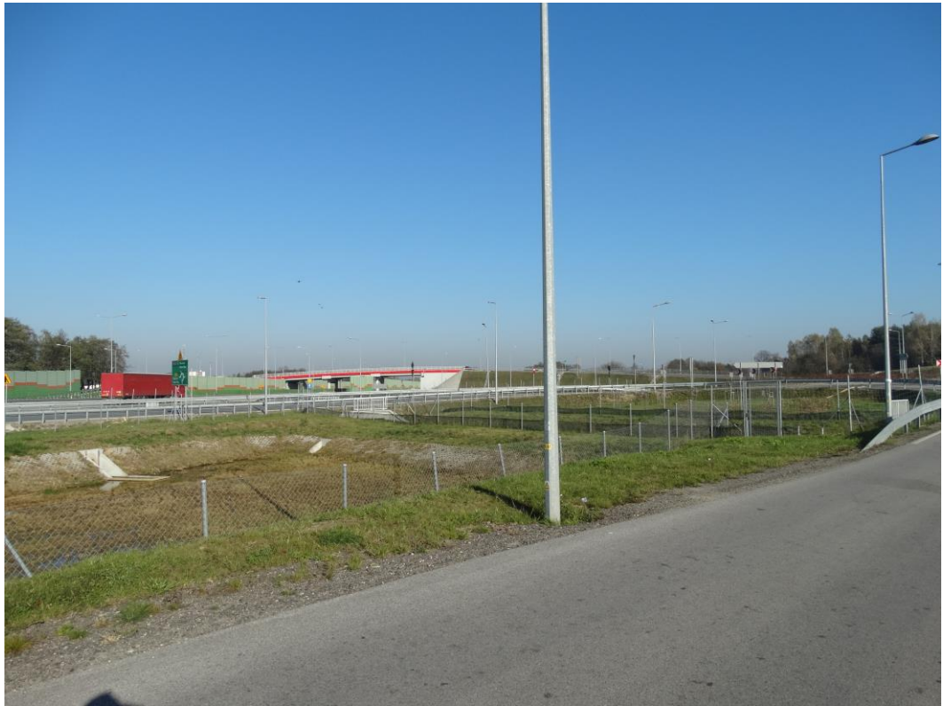
Zdjęcie Nr 15. Droga S8, wgląd na wiadukt w ul. Krakowskiej.
