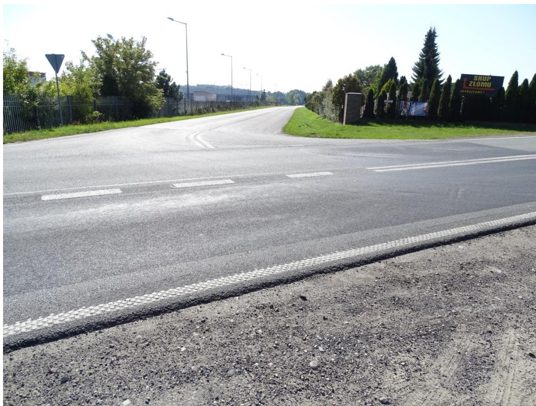
Wgląd na drogę dojazdową od strony drogi S8.
