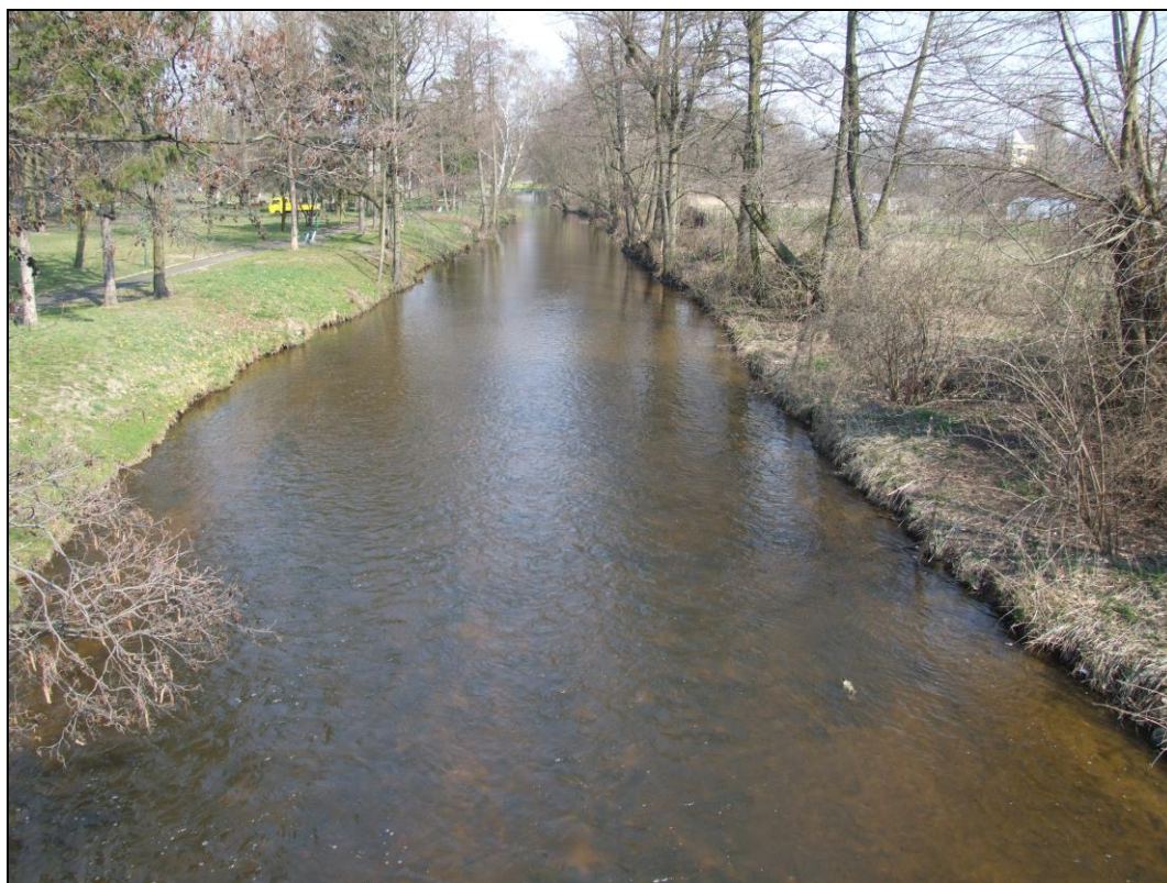
Zdjęcie Nr 3. Wgląd na koryto rz. Rawki od strony ul. Fawornej. Po stronie lewej „Park Miejski” wpisany do rejestru zabytków.
