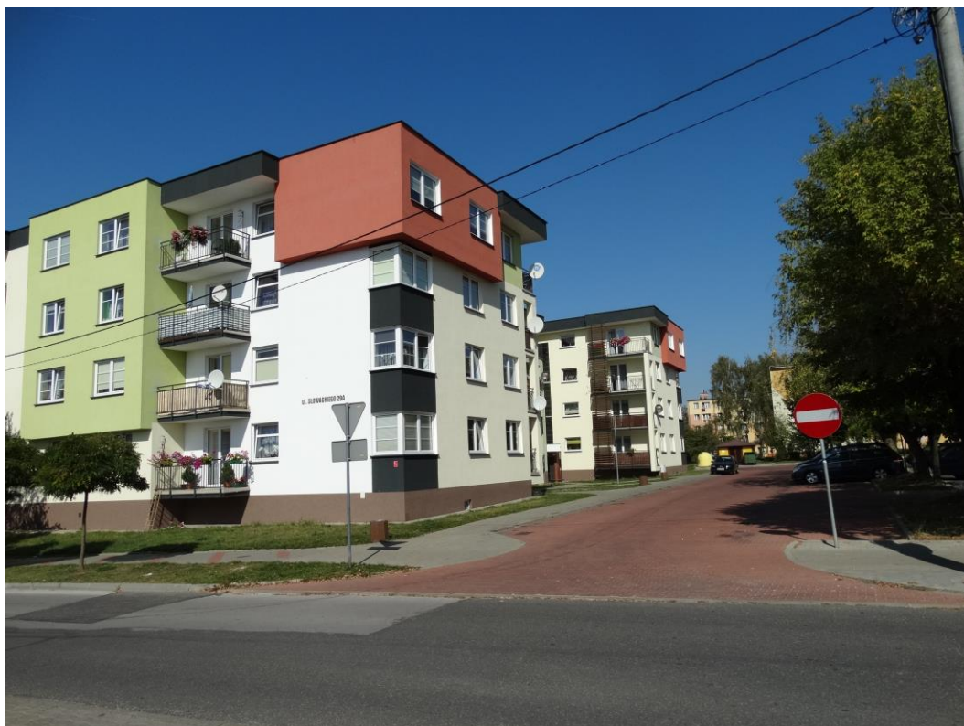
Zdjęcie Nr 27. Zabudowa wielorodzinna z uliczką osiedlową.
