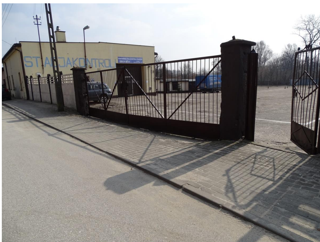
Zdjęcie Nr 92. Stacja kontroli pojazdów na bazie technicznej LOK.
