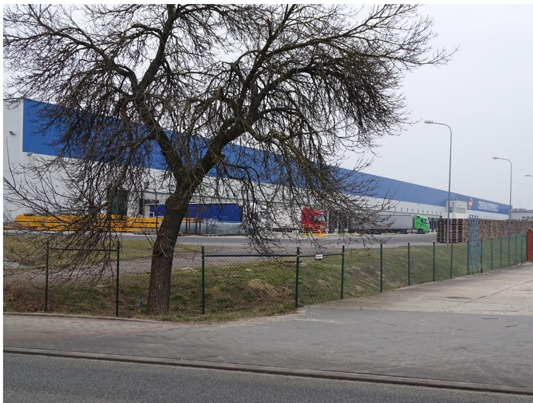
Zdjęcie Nr 103. Kompleks magazynowy na działce Nr 706/1, wgląd w kierunku wschodnim.
