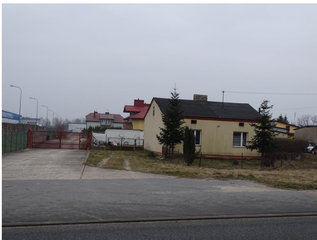
Zdjęcie Nr 102. Zabudowa mieszkaniowa jednorodzinna w rejonie działek Nr 227/4 – 708/3, wgląd w kierunku południowo-wschodnim.
