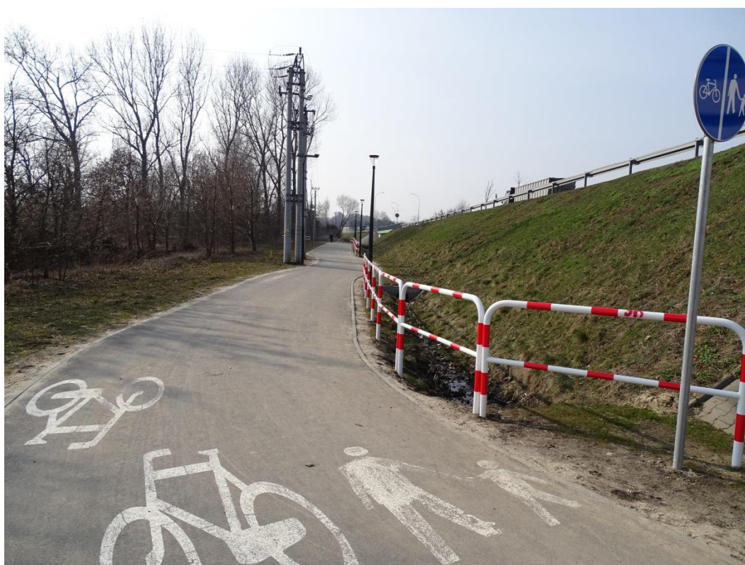
Zdjęcia Nr 6. Ścieżka pieszo-rowerowa, odcinek w pasie drogowym drogi Nr 72.
