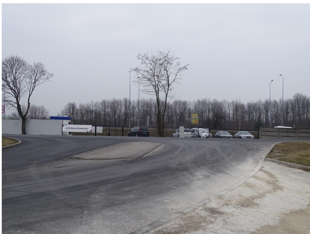
Zdjęcia Nr 36. Wylot drogi wyjazdowej z terenów magazynowych na ul. Białą.
