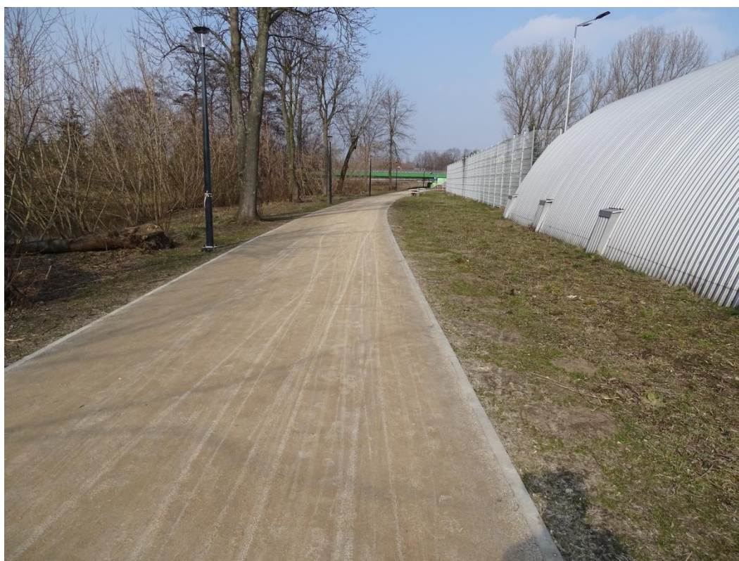
Zdjęcia Nr 2. Ścieżka pieszo-rowerowa, wgląd w kierunku północnym do mostu drogi Nr 72.
