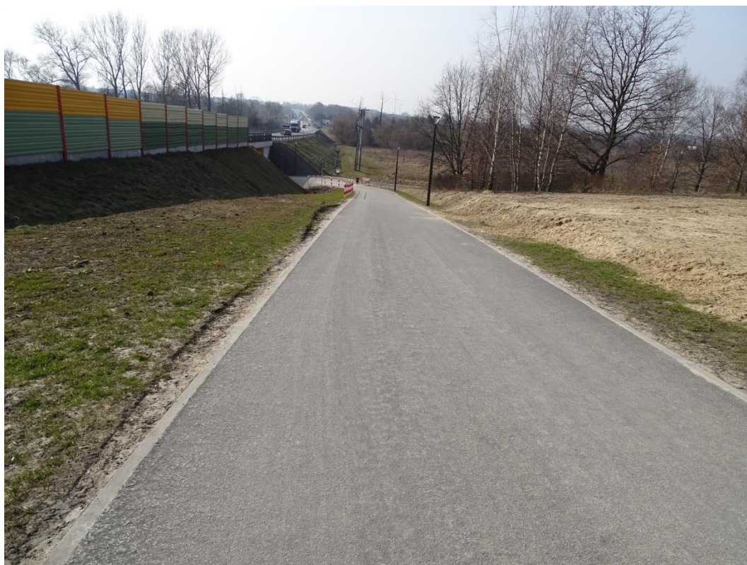
Zdjęcie Nr 129. Ścieżka pieszo-rowerowa, odcinek przy tunelu pod drogą Nr 72.
