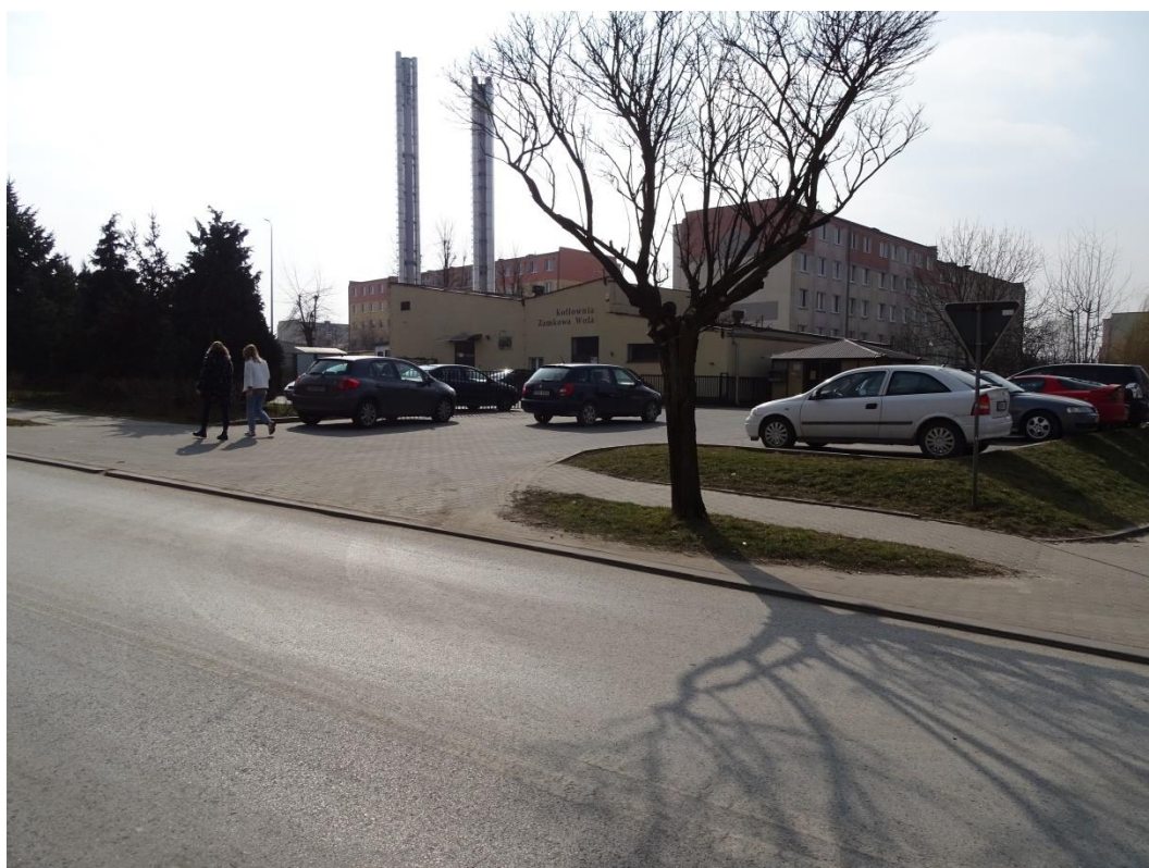
Zdjęcie Nr 81. Kotłownia osiedlowa.
