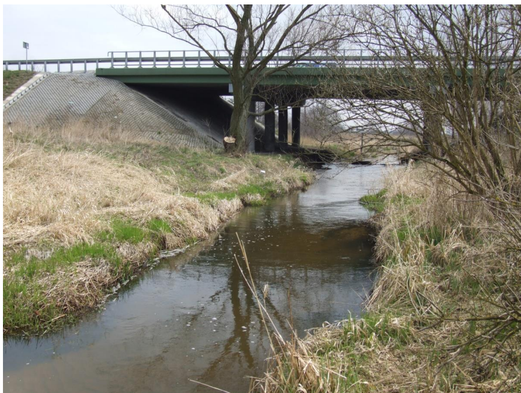
Zdjęcia Nr 22. Koryto rzeki w rejonie mostu ul. Targowej, wgląd w kierunku wschodnim.
