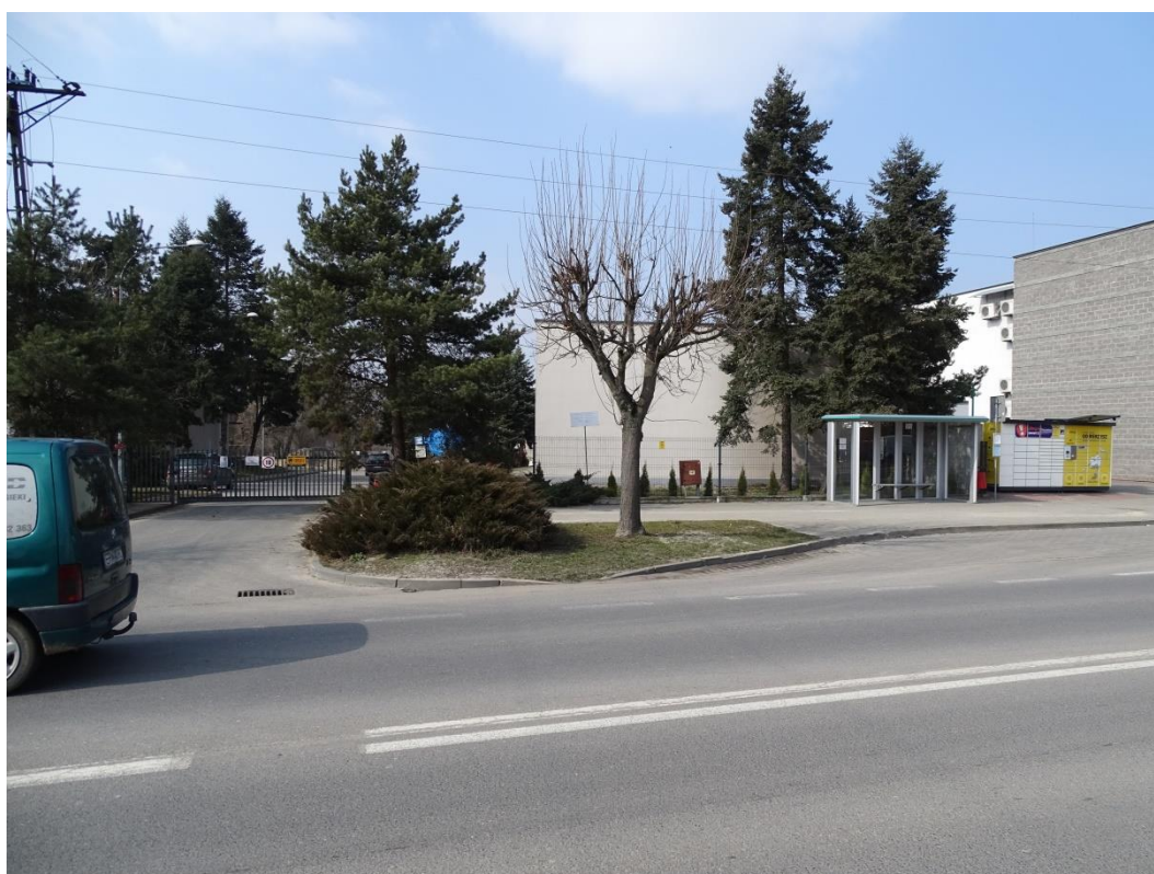
Zdjęcie Nr 68. Zabudowa obsługi urządzeń kanalizacji sanitarnej i przepompownia ścieków.
