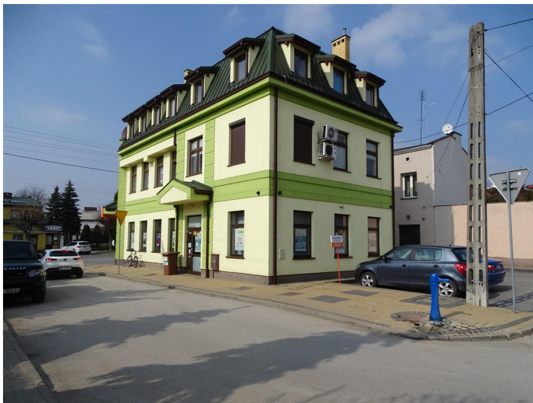
Zdjęcie Nr 93. Budynek banku Spółdzielczego od strony południowo-wschodniej.
