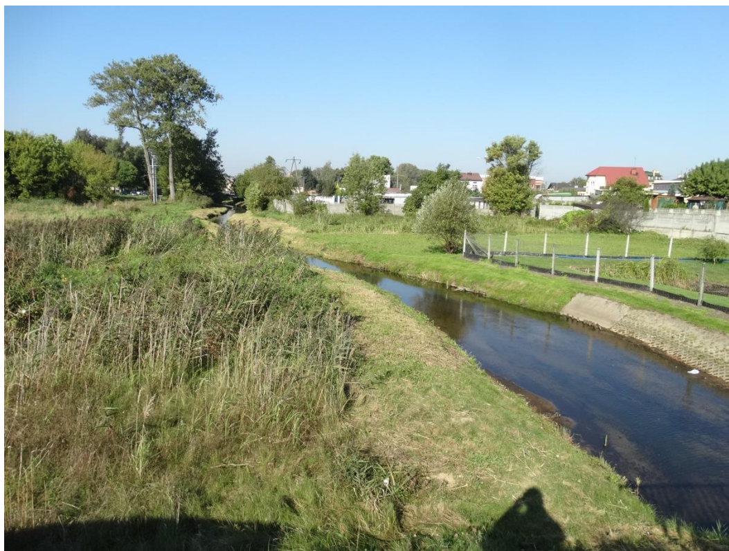
Zdjęcia Nr 19. Koryto rzeki w rejonie zabudowy przy ul. Łąkowej wgląd w kierunku zachodnim z mostu ul. Targowej.
