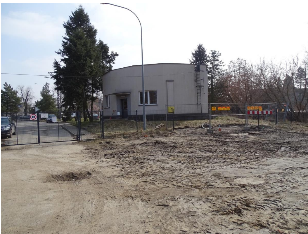
Zdjęcie Nr 146. Obiekty przepompowni ścieków.
