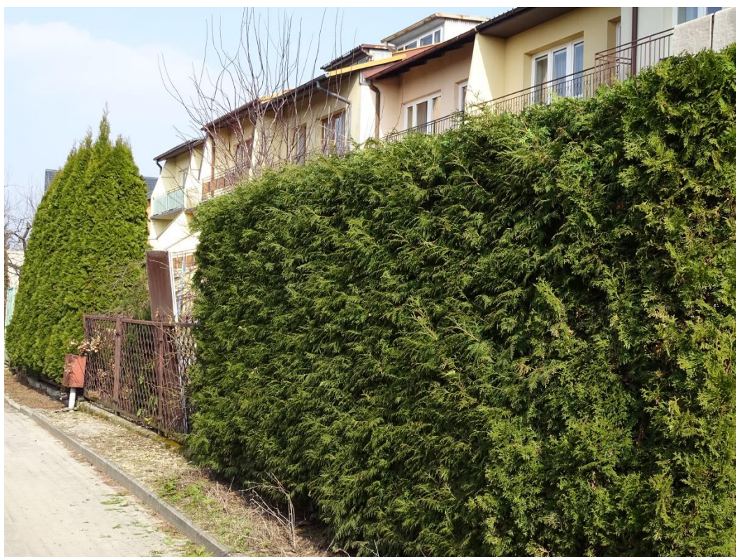
Zdjęcie Nr 53. Zabudowa mieszkaniowa jednorodzinna szeregową, wgląd od strony zachodniej.
