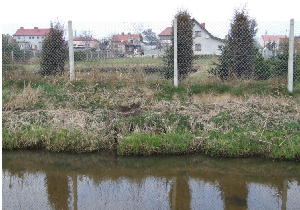
Zdjęcia Nr 20. Koryto rzeki w rejonie zabudowy przy ul. Łąkowej wgląd w kierunku północnym.
