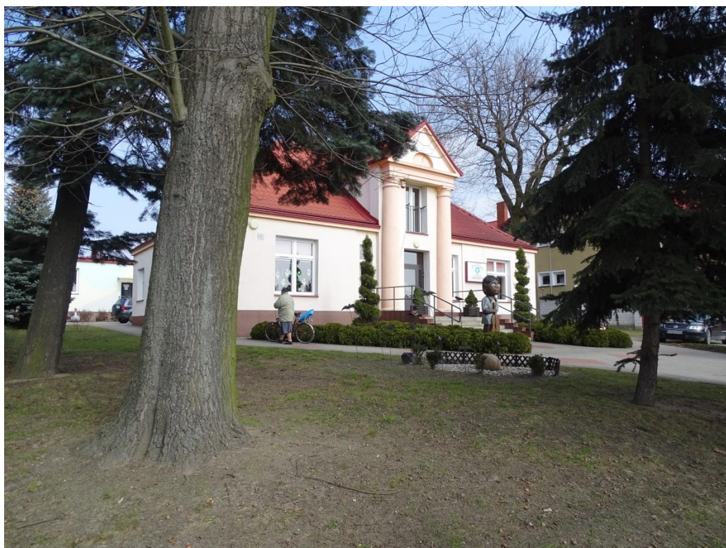
Zdjęcie Nr 170. Budynek przedszkola.
