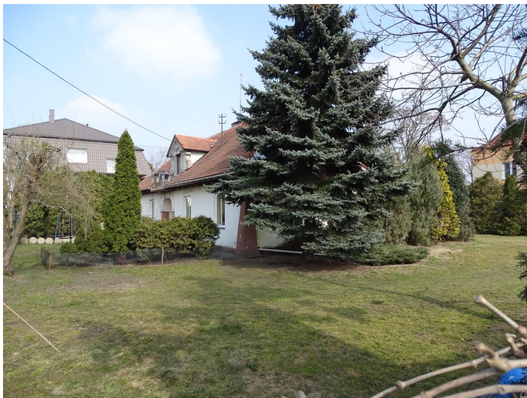
Zdjęcie Nr 173. Budynek mieszkalny rejon działki Nr 245, wgląd od strony zachodniej.
