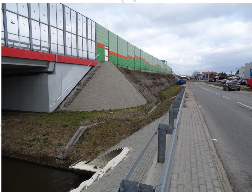
Zdjęcie Nr 14. Ekrany akustyczne drogi S8 przy ul. Opoczyńskiej.
