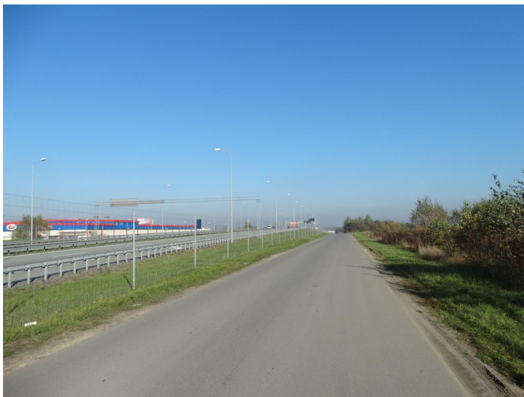
Zdjęcie Nr 3. perspektywa drogi S8 z drogą serwisową w kierunku północnym.
