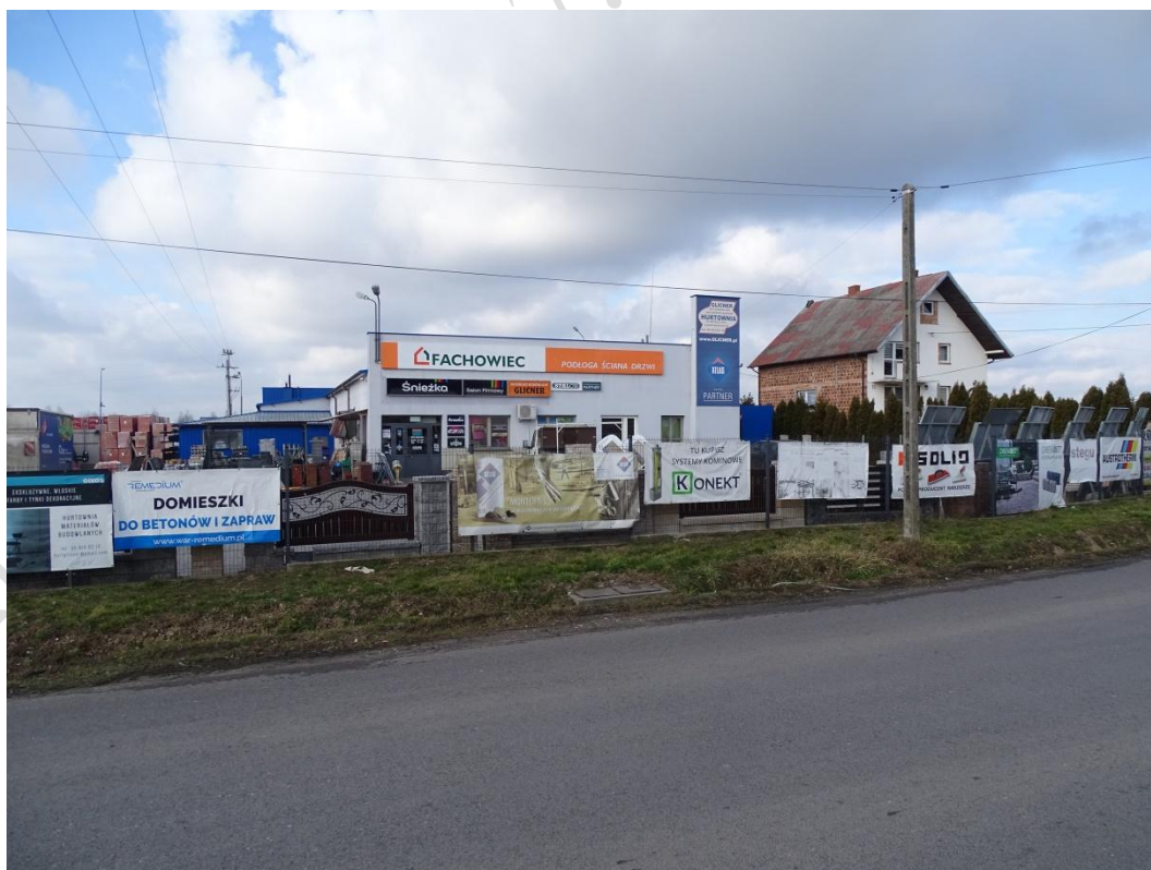
Zdjęcie Nr 52. Zabudowa magazynowa i dom jednorodzinny (rejon działek Nr 221/9 do 222/2), wgląd od strony wschodniej.
