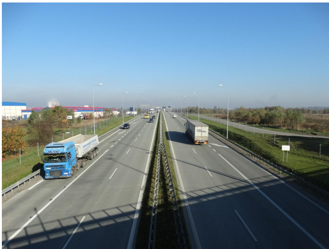
Zdjęcie Nr 13. Perspektywa drogi S8 w kierunku północnym.
