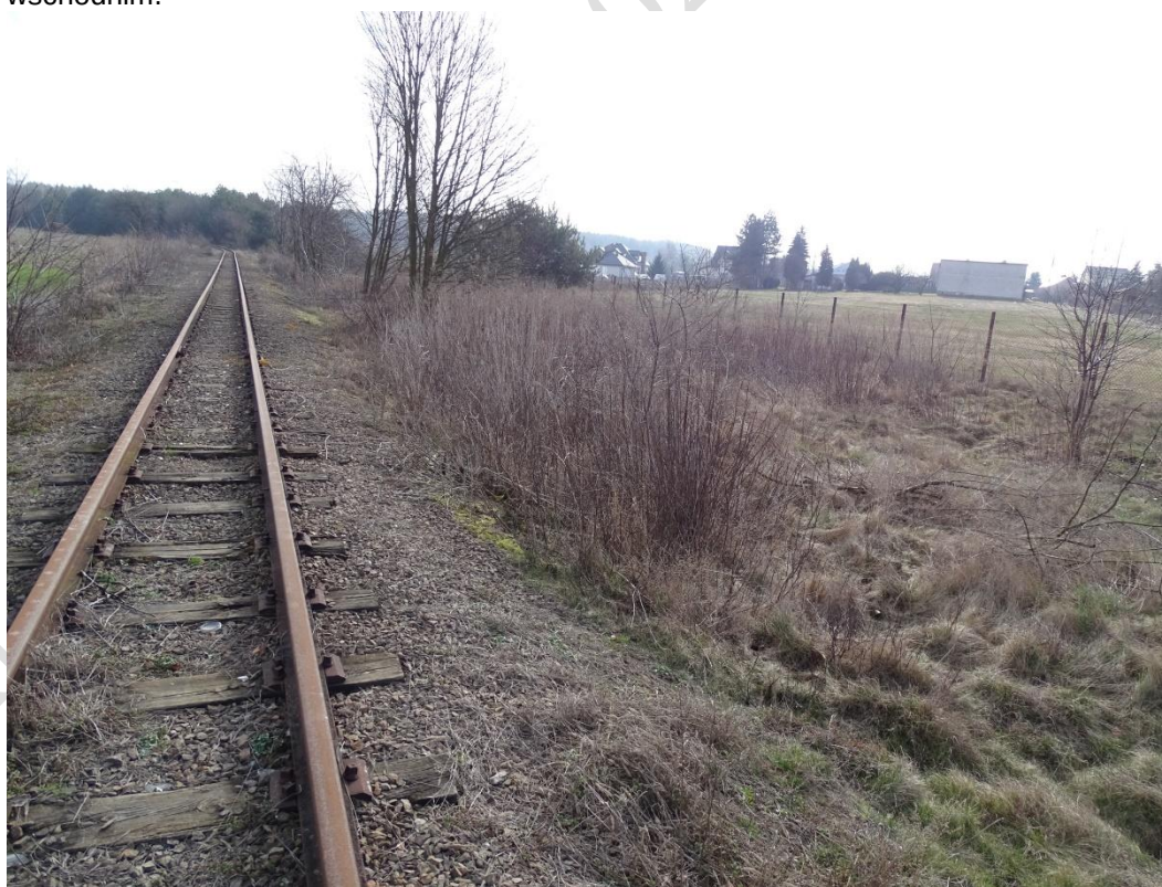
Zdjęcie Nr 82. Wgląd na kolejkę wąskotorową (rejon działek Nr 69 do 71/4) w kierunku wschodnim.
