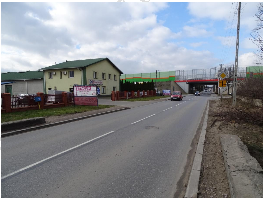
Zdjęcie Nr 66. Wiadukt drogi S8 nad ul. Zamkowa Wola i zabudowa usługowa handlu hurtowego (działka Nr 270), widok od strony wschodniej.
