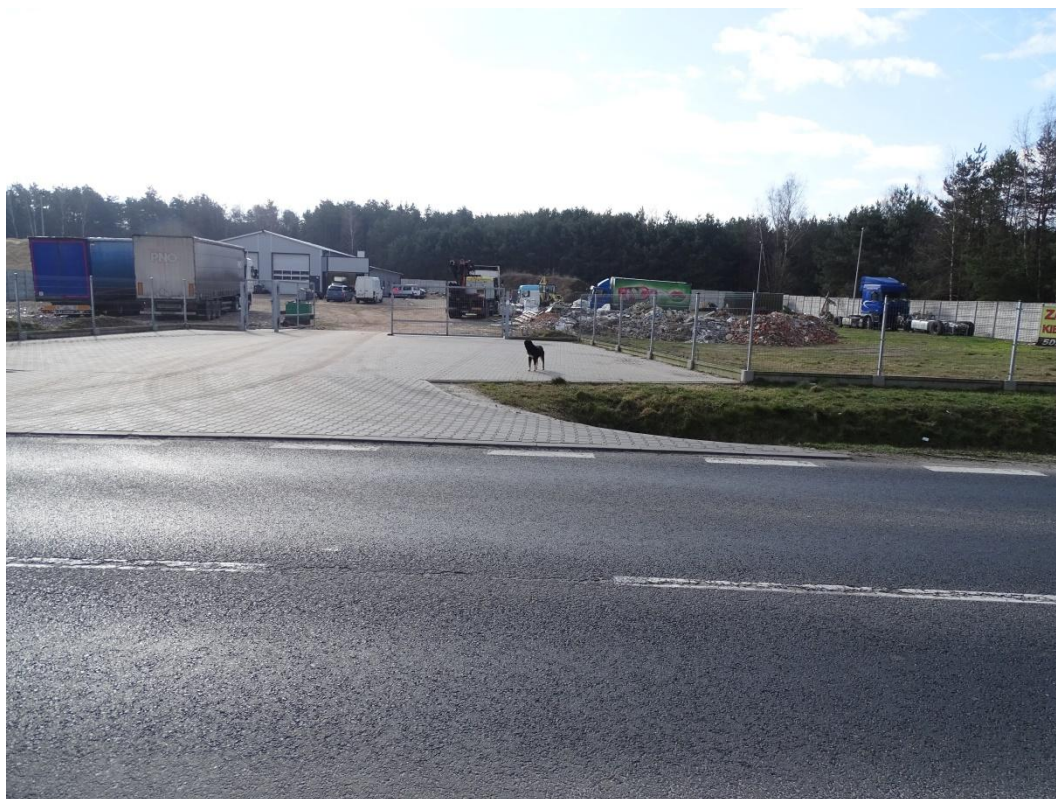
Zdjęcie Nr 35. Wgląd na tereny zabudowy magazynowej w trakcie realizacji (rejon działek Nr 162 do 165) z drogi Nr 725 w kierunku wschodnim.
