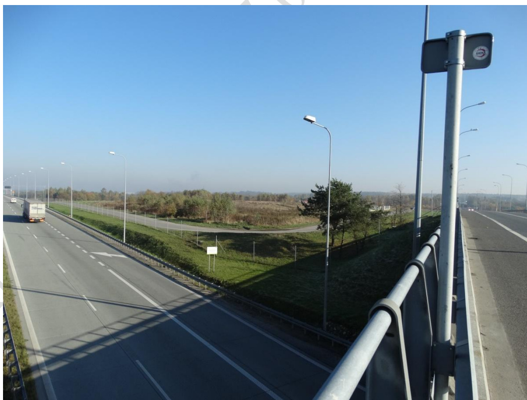
Zdjęcie Nr 12. Wgląd z wiaduktu drogi Nr 725, nad drogą S8 w kierunku południowo-wschodnim.
