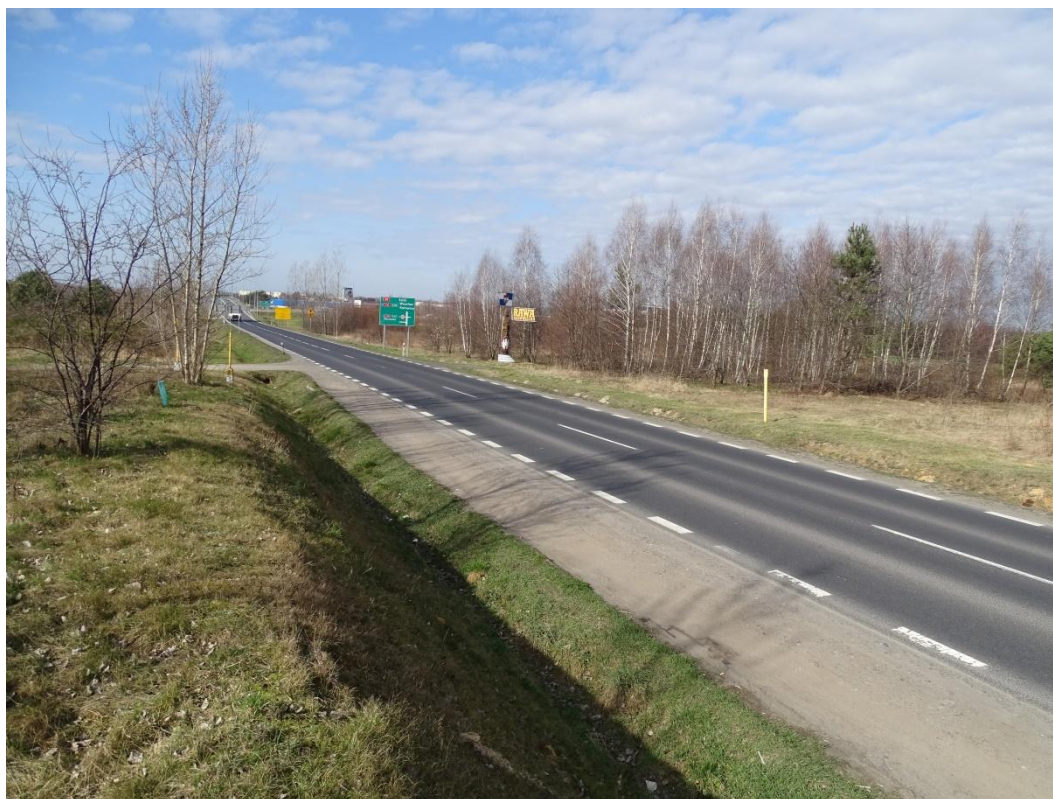
Zdjęcie Nr 17. Perspektywa drogi Nr 725 w kierunku zachodnim, odcinek dojazdowy do wiaduktu nad drogą S8.
