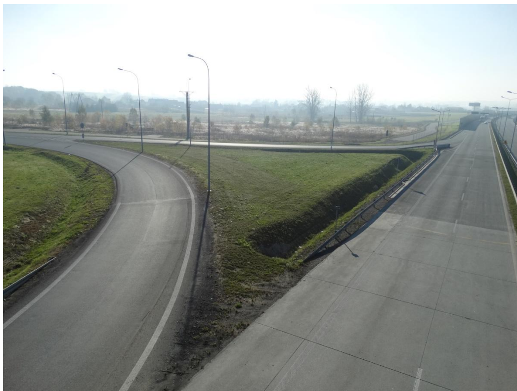
Zdjęcie Nr 11. Wgląd z wiaduktu drogi Nr 725, nad drogą S8 w kierunku południowym.
