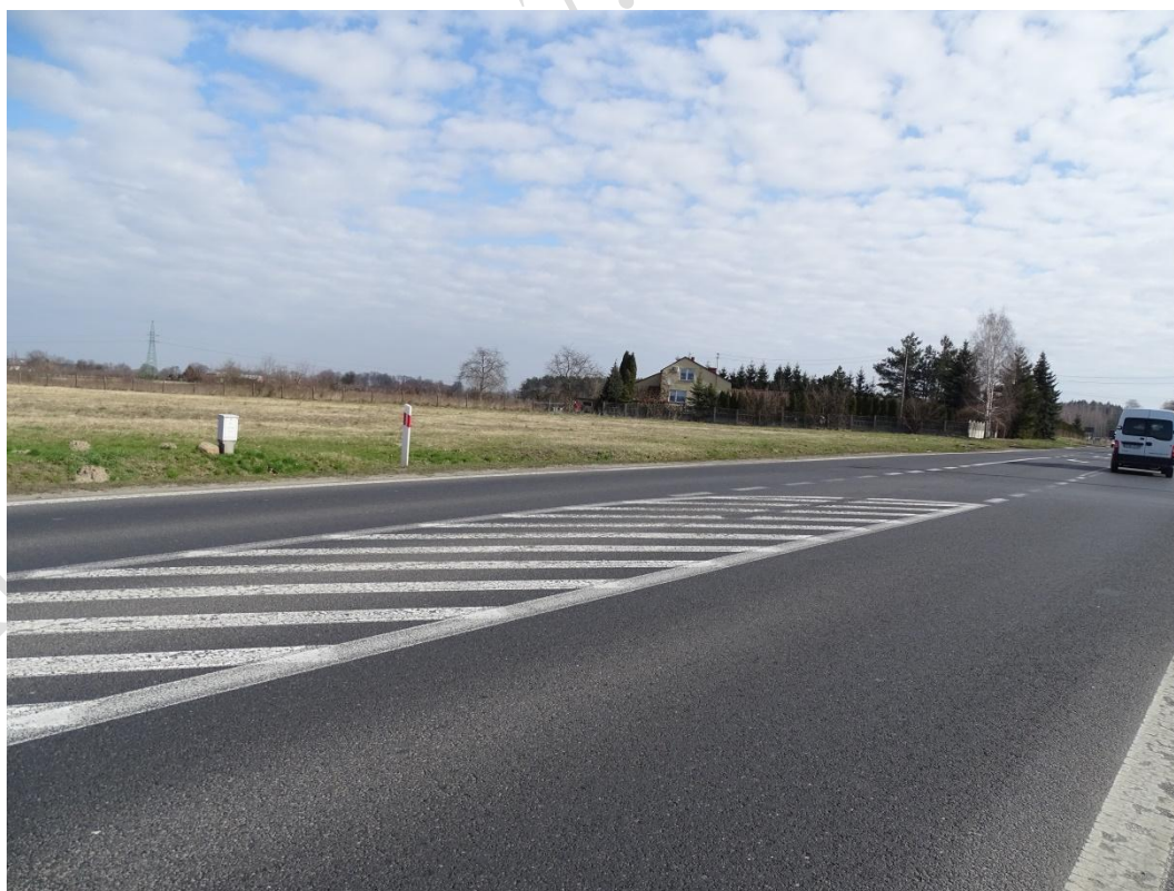
Zdjęcie Nr 24. Wgląd na tereny rolne i zabudowę jednorodzinną (rejon działek Nr 65/2 do 66/2) z drogi Nr 725 w kierunku północno-wschodnim.
