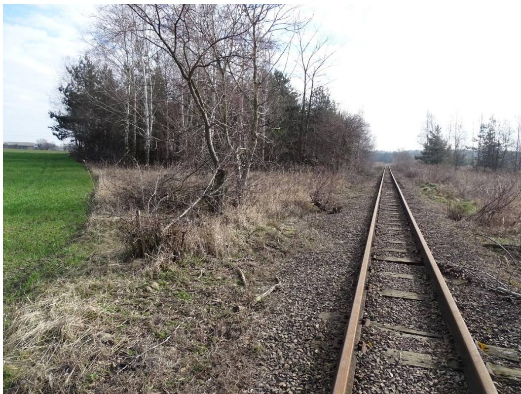
Zdjęcie Nr 83. Wgląd na kolejkę wąskotorową (rejon działek Nr 60/3 do 62) w kierunku wschodnim.
