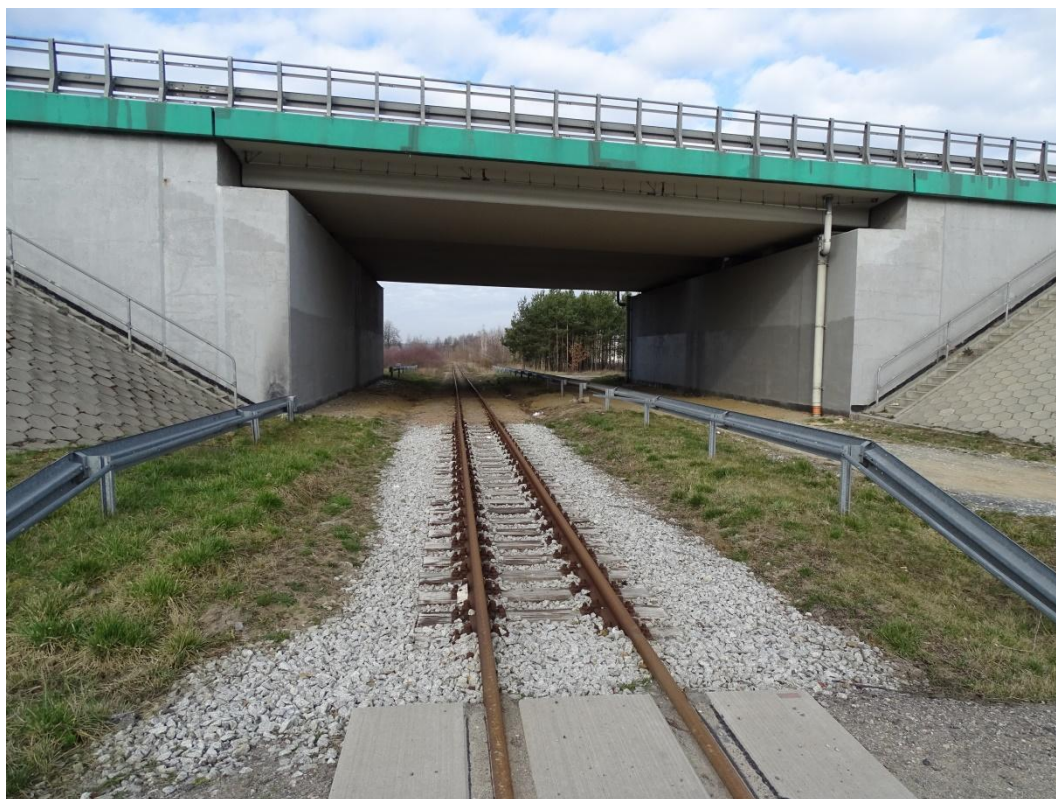
Zdjęcie Nr 93. Kolejka wąskotorowe w świetle wiaduktu drogi S8.
