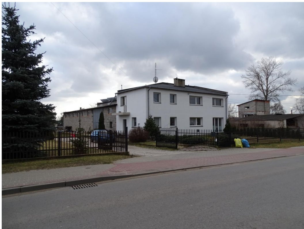
Zdjęcie Nr 39. Wgląd na zabudowę przemysłową (rejon działek 263 i 264) w kierunku południowym.
