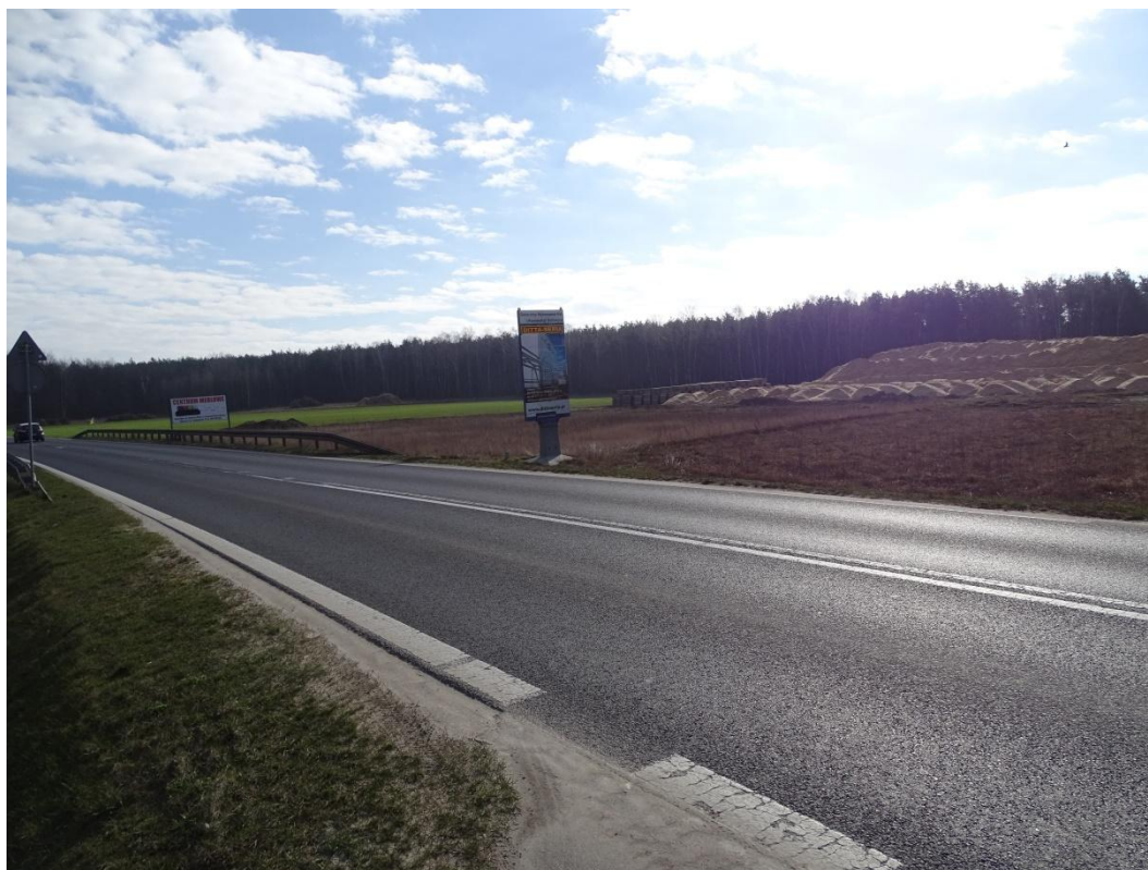
Zdjęcie Nr 33. Wgląd na tereny rolne i tereny zabudowy magazynowej w trakcie realizacji (rejon działek Nr 162 do 165) z drogi Nr 725 w kierunku wschodnim.
