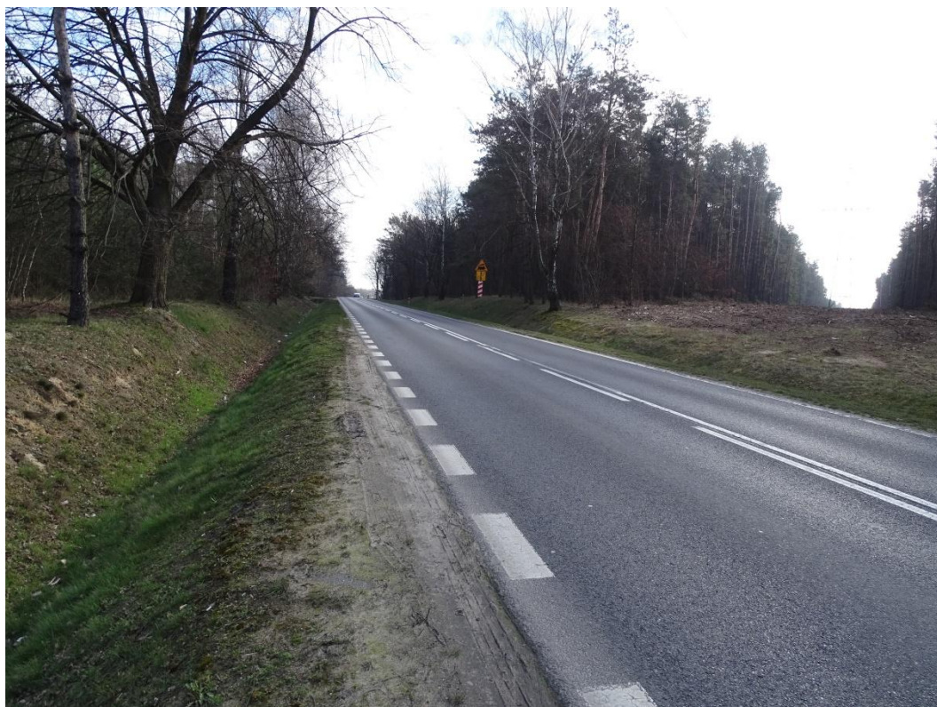
Zdjęcie Nr 37. Wgląd na użytki leśne i korytarz linii elektroenergetycznej 110 KV z drogi Nr 725 w kierunku wschodnim.
