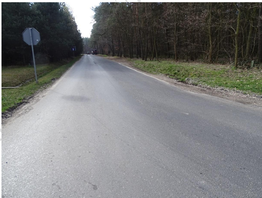
Zdjęcie Nr 32. Perspektywa drogi Nr 725 w kierunku zachodnim (odcinek wschodni drogi).
