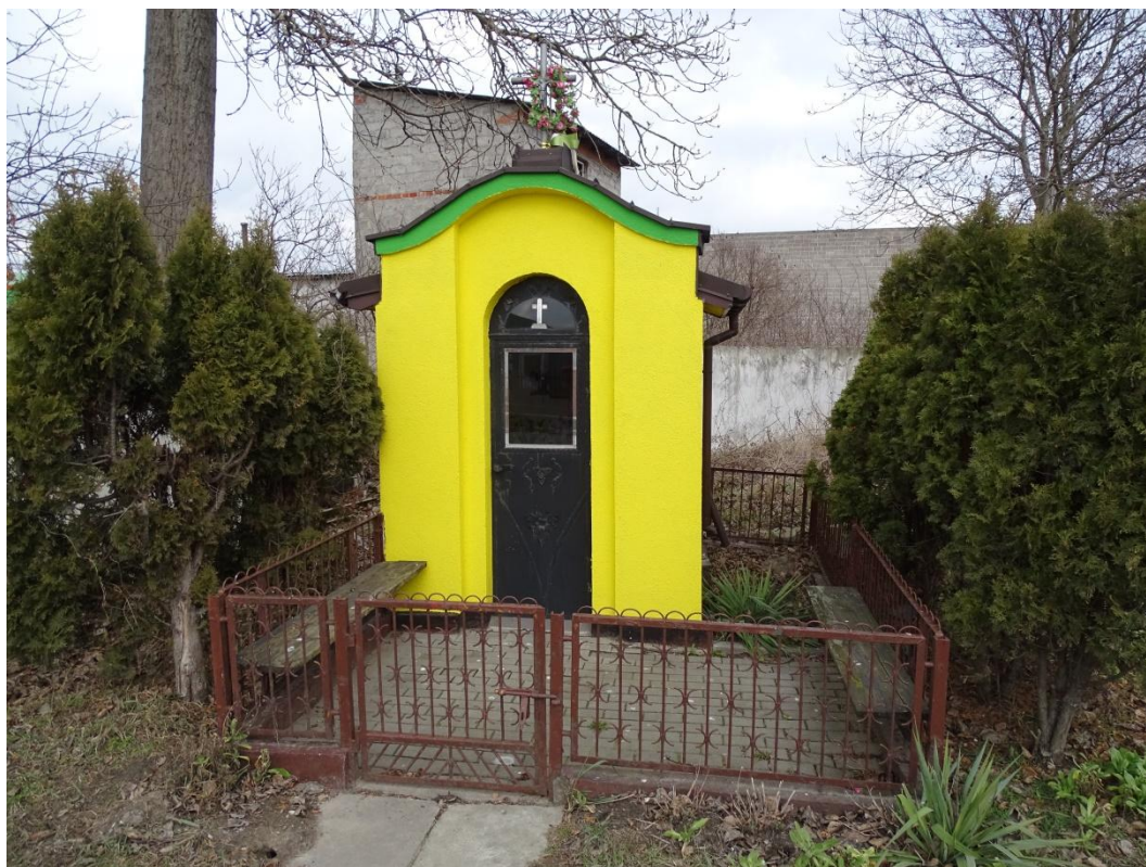
Zdjęcie Nr 65. Zabytkowa kapliczka na działce Nr 265, widok od strony południowo-zachodniej.
