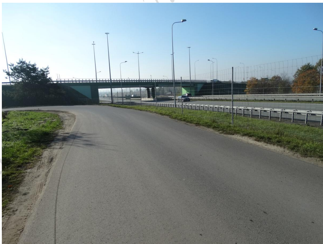
Zdjęcie Nr 6. Perspektywa drogi S8 z wiaduktem drogi Nr 725 w kierunku południowym.
