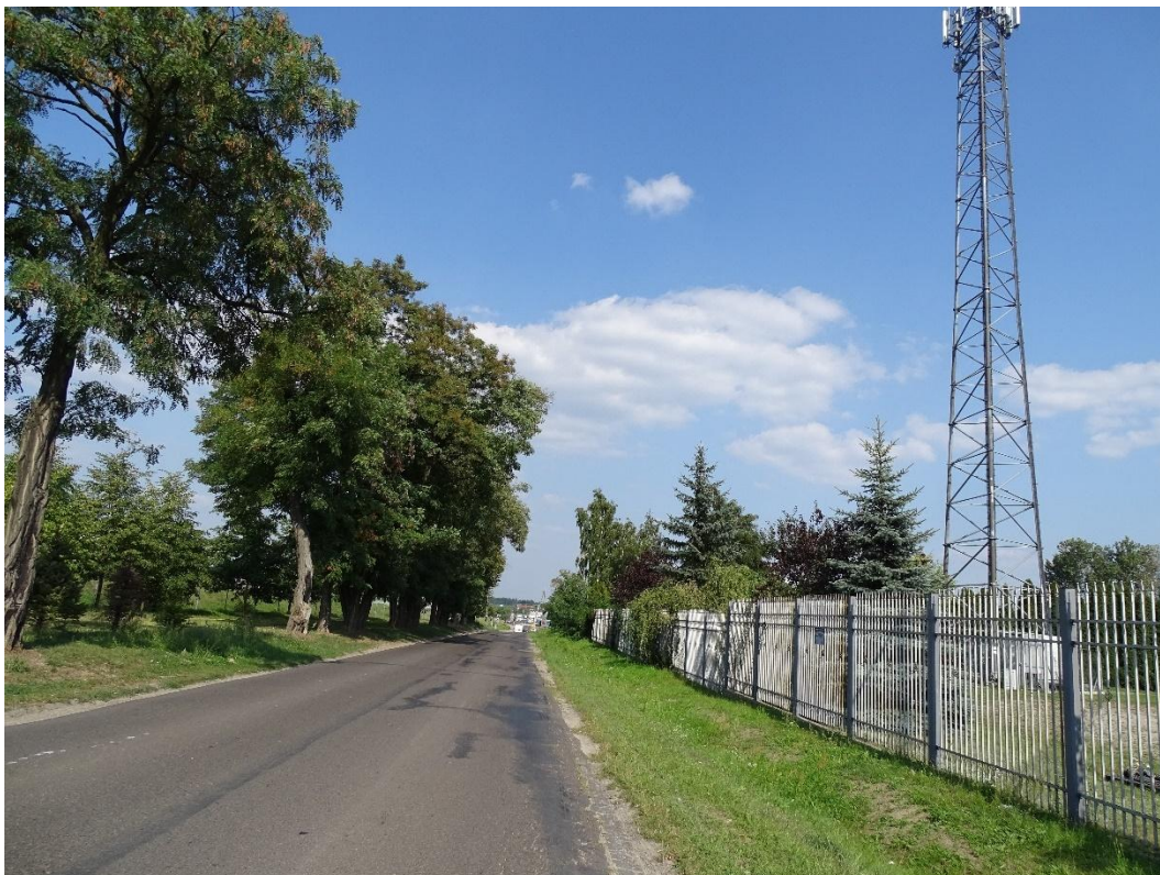
Stacja bazowa telefonii komórkowej.
