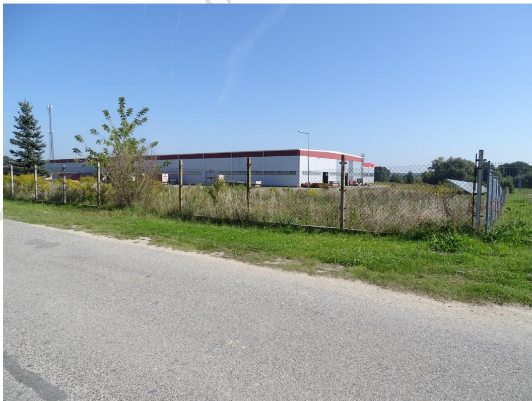
Zabudowa produkcyjna na działce Nr 6/12, wgląd z drogi dojazdowej (działka Nr 6/19 w kierunku wschodnim).
